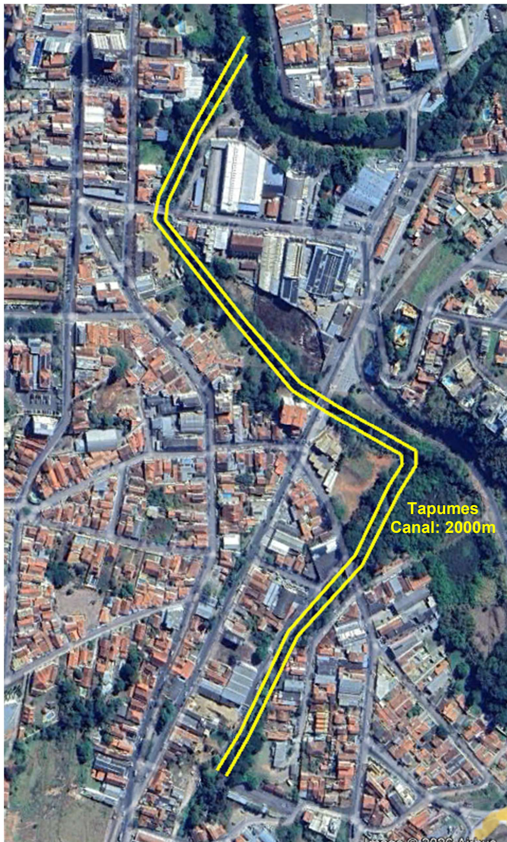
Figura 3 – Cercamento por tapumes das áreas de intervenção na bacia do Rib. dos Machados – Canalização
