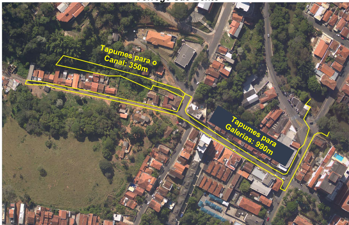
Figura 2 – Cercamento da área de intervenção das barragens 1 e 2 na bacia do Córrego São Bento
