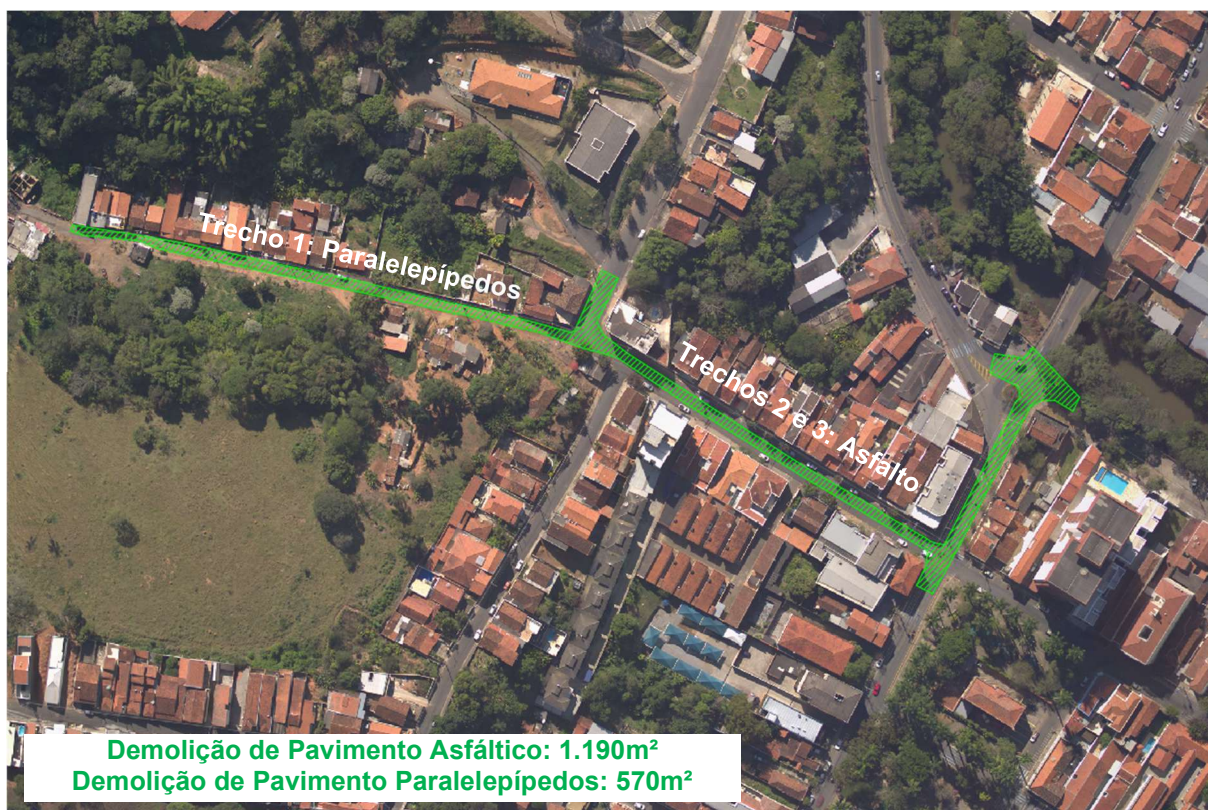
Figura 3 – Áreas de demolição e recomposição de pavimento na bacia do São Bento
