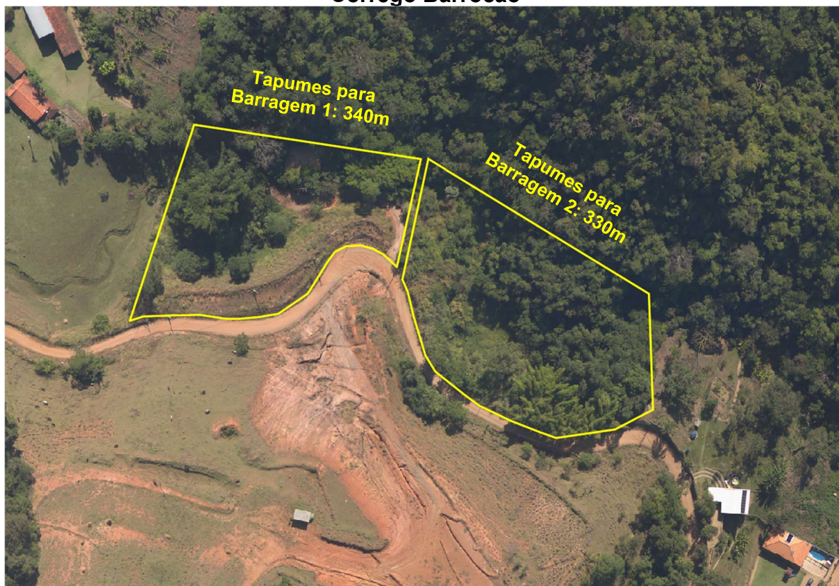
Figura 2 – Cercamento da área de intervenção das barragens 1 e 2 na bacia do Córrego Barroco
