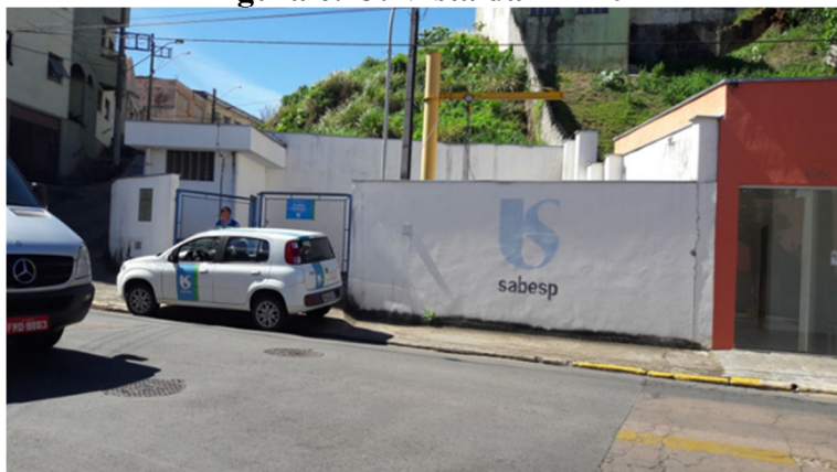
Figura 6.43: Vista da EEE-9
