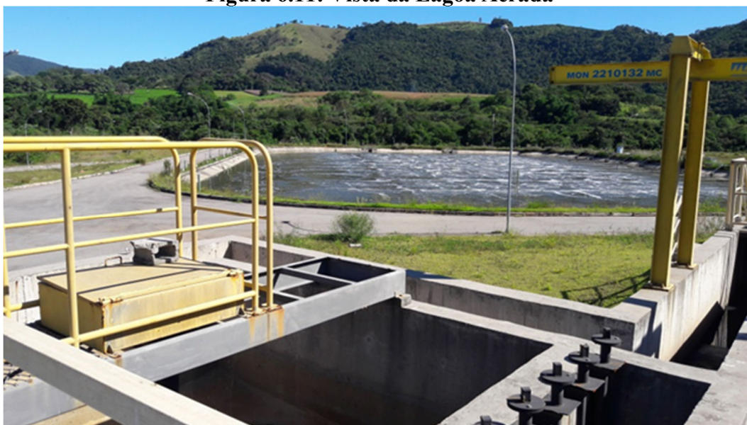
Figura 6.11: Vista da Lagoa Aerada
