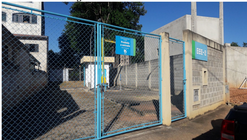
Figura 6.22: Vista da EEE-2
