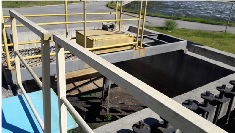
Figura 6.9: Desarenador
