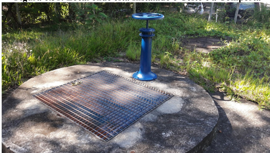
Figura 6.31: Local onde está Instalado o Cesto e a Comporta
