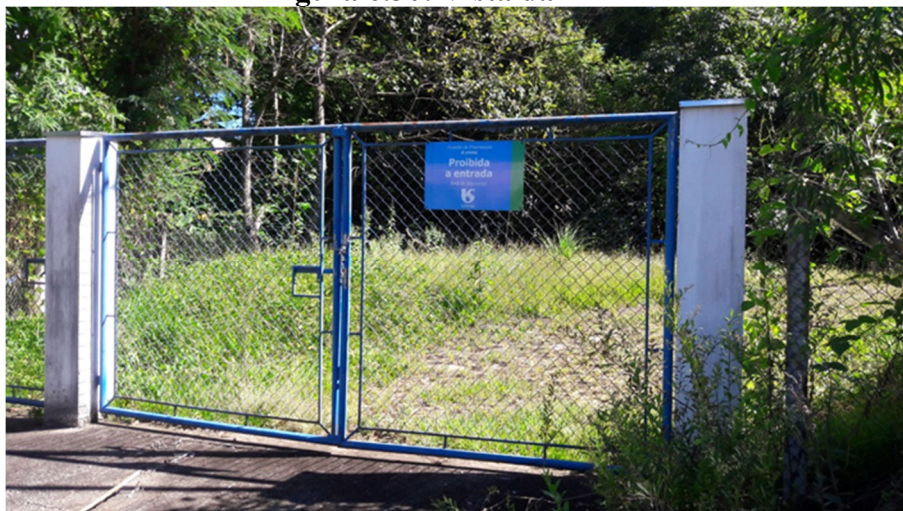
Figura 6.30: Vista da EEE-4
