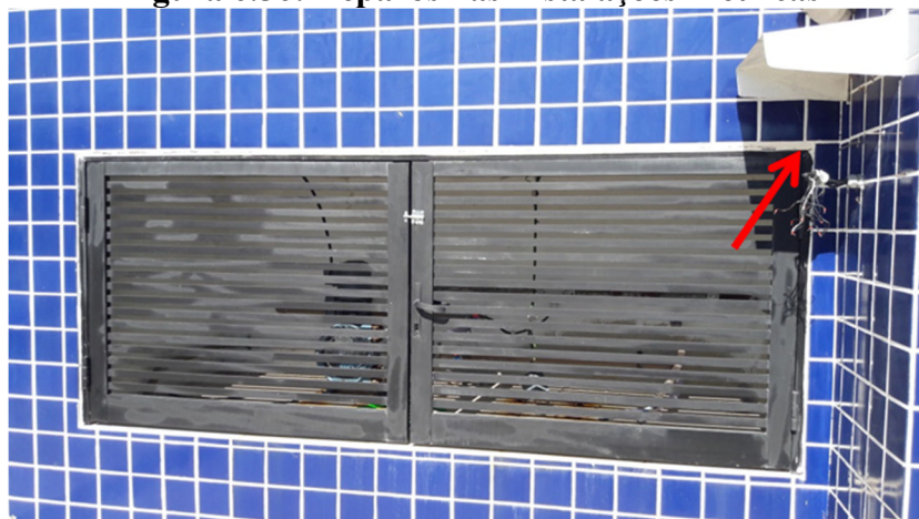
Figura 6.56: Reparos nas Instalações Elétricas
