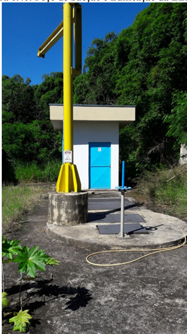
Figura 6.46: Poço de Sucção e Edificação da EEE-L15
