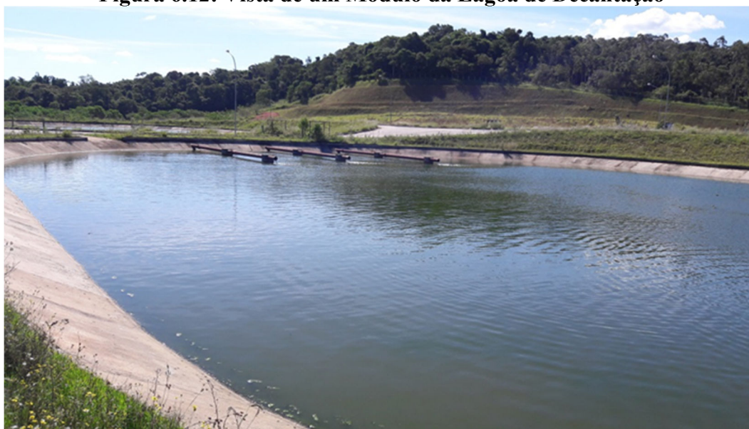
Figura 6.12: Vista de um Módulo da Lagoa de Decantação
