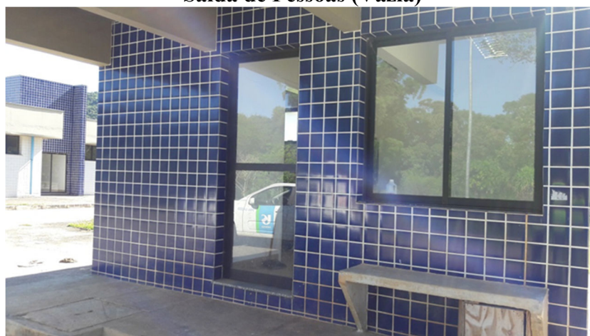
Figura 6.55: Sala Onde Deveria Haver o Controle de Entrada e Saída de Pessoas (Vazia)
