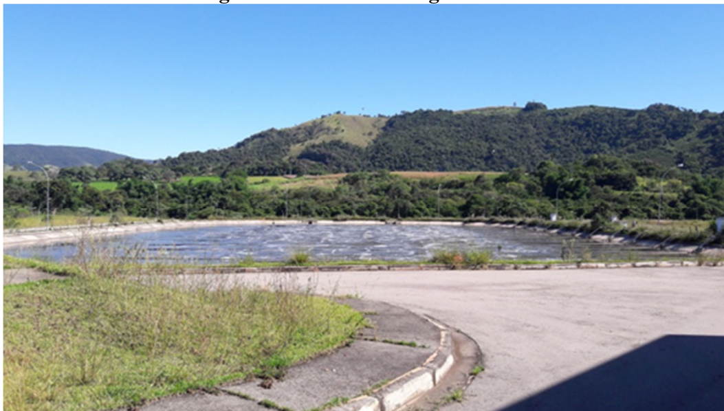
Figura 6.10: Vista da Lagoa Aerada
