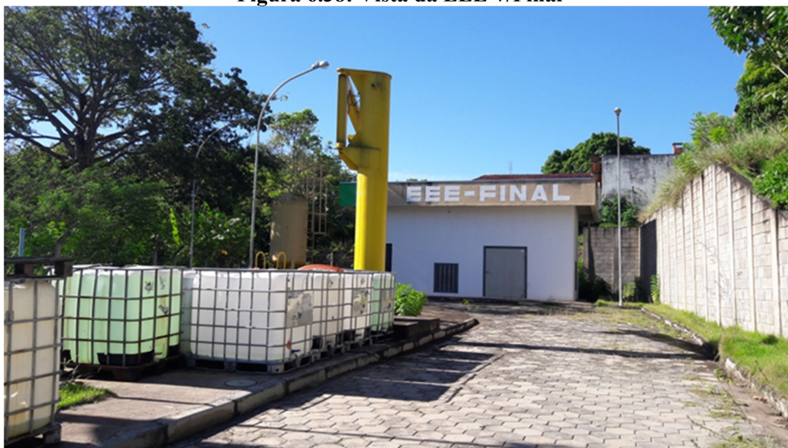
Figura 6.38: Vista da EEE-7/Final
