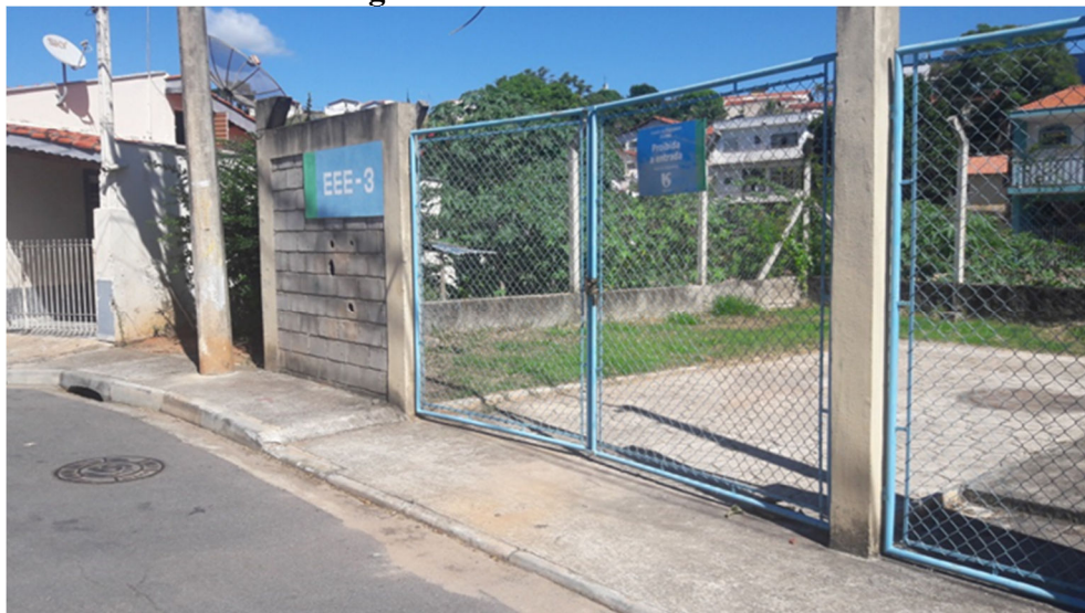
Figura 6.25: Vista da EEE-3
