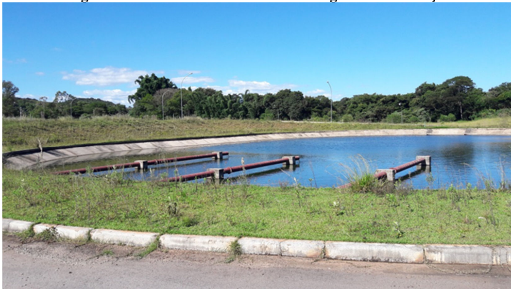
Figura 6.13: Vista de um Módulo da Lagoa de Decantação
