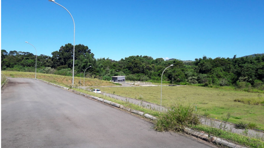
Figura 6.14: Depósito de Cloro e Tanque de Contato
