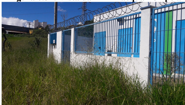
Figura 6.52: Vista da EEE Lacqua Pompeia
