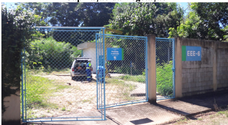
Figura 6.35: Vista da EEE-6 e Funcionários da SABESP Iniciando a Capinação da Vegetação
