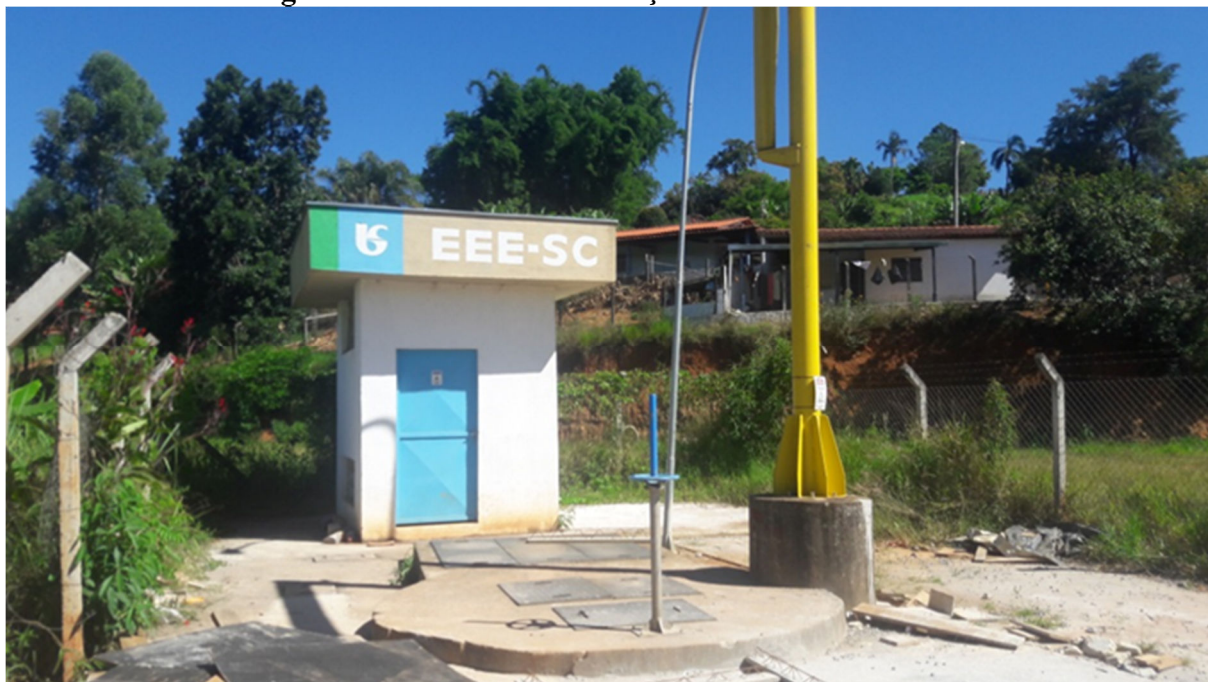
Figura 6.47: Vista da Edificação da EEE Santa Cruz
