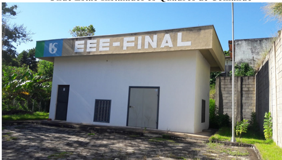
Figura 6.41: Edificação da EEE-7/Final, Onde Estão Instalados os Quadros de Comando
