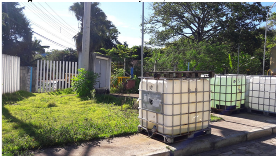
Figura 6.40: Bombonas de Hydrox, Utilizadas Contra Odores
