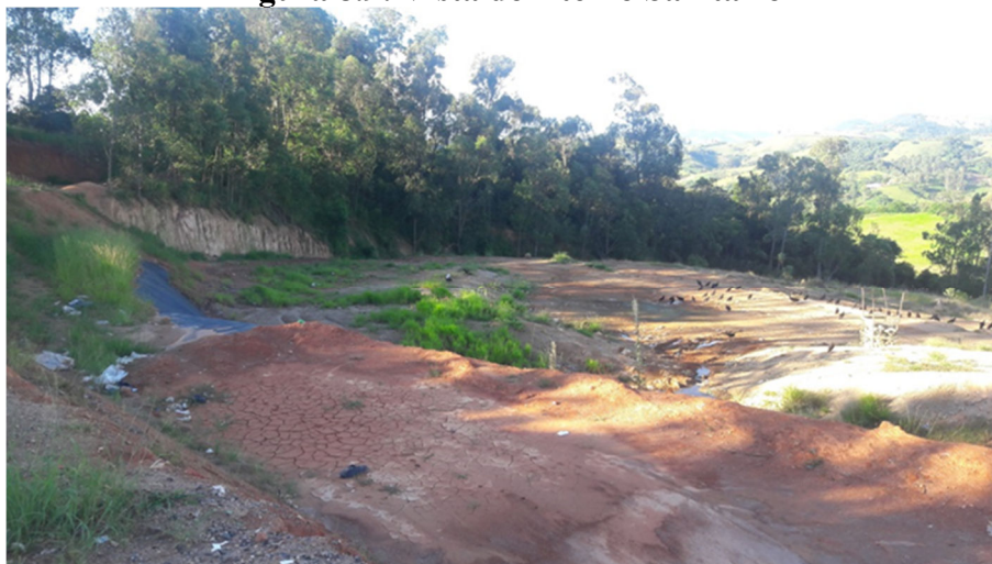
Figura 8.9: Vista do Aterro Sanitário
