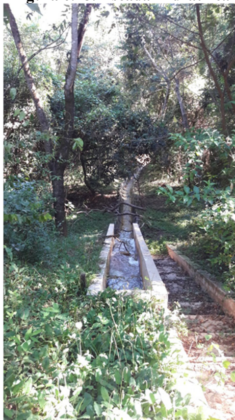
Figura 6.18: Escada Hidráulica
