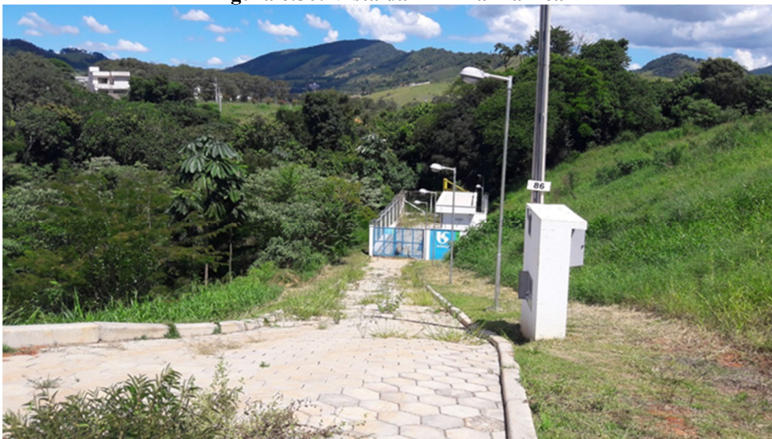
Figura 6.50: Vista da EEE Palma Real
