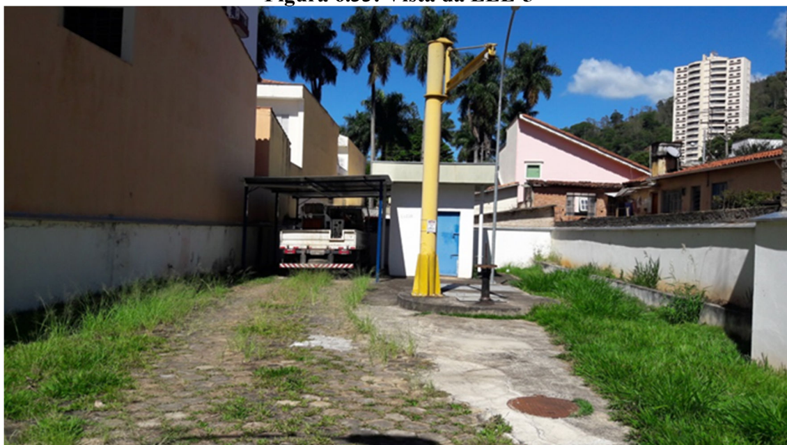
Figura 6.33: Vista da EEE-5
