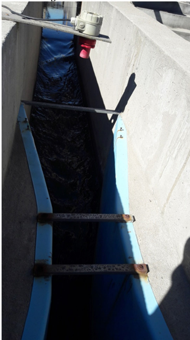
Figura 6.7: Calha Parshall
