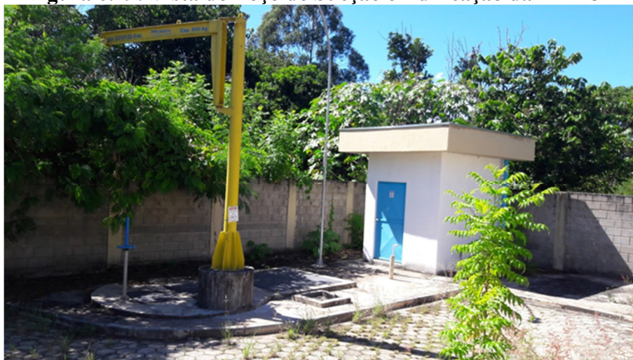
Figura 6.29: Vista do Poço de Sucção e Edificação da EEE-3A
