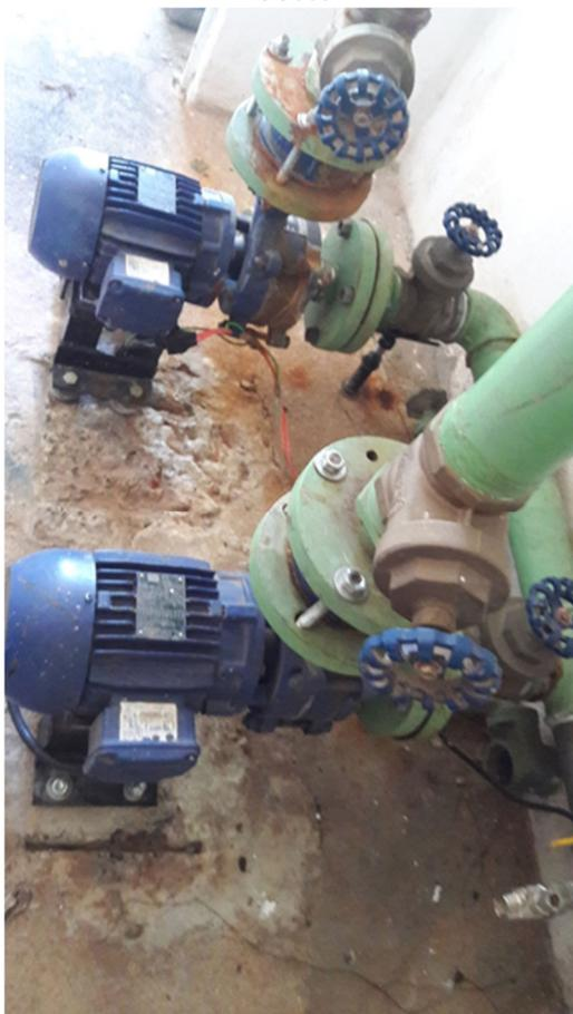
**Figura 5.43: Falta de Reparo na Travessia do Tubo na Parede**
