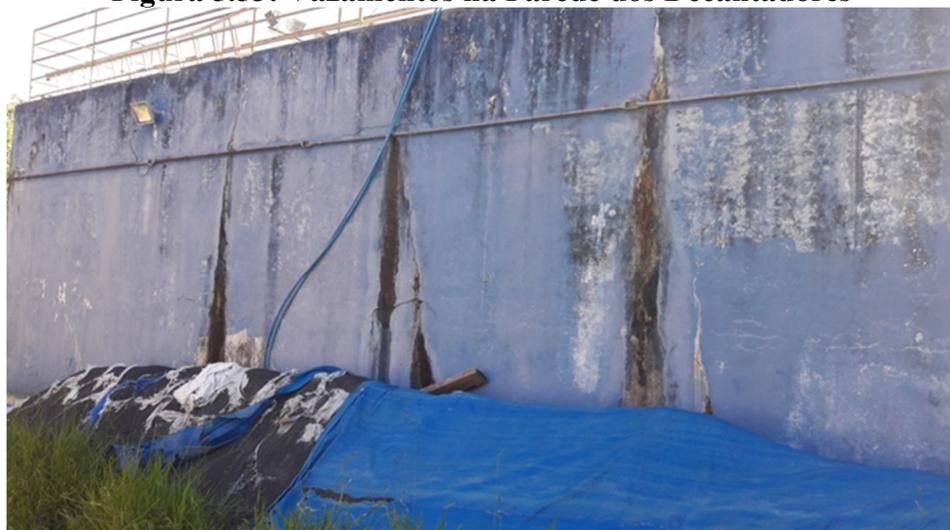
**Figura 5.54: Vazamentos na Parede dos Filtros**
