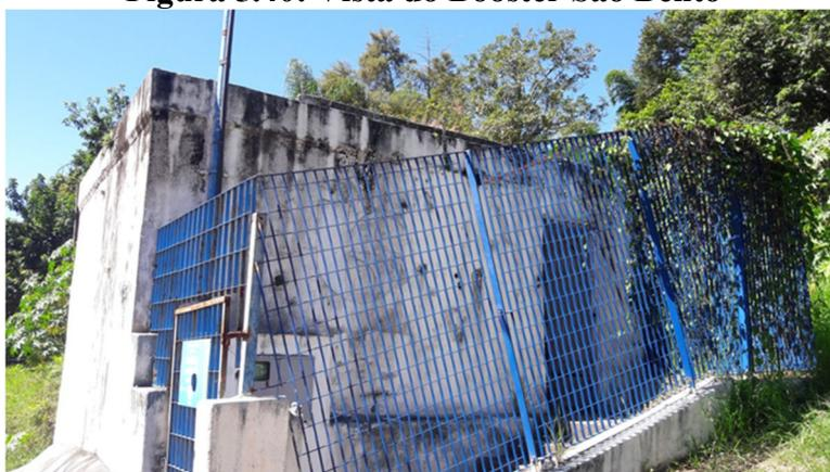
**Figura 5.41: Vista do Booster São Bento com Infiltração possível de Água na Parede**
