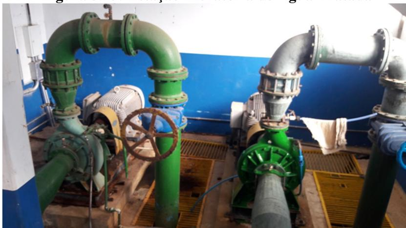
**Figura 5.24: Estação Elevatória de Água Tratada**
