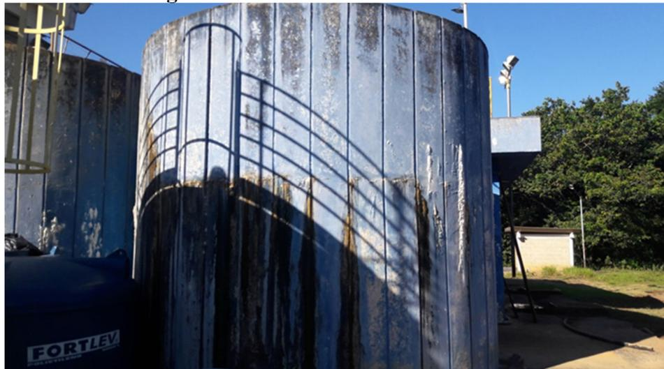
**Figura 5.53: Vazamentos na Parede dos Decantadores**
